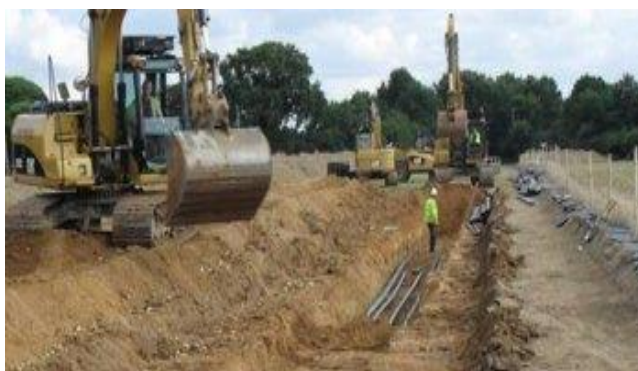
Fot. 3.4. Pojazd z przyczepą kablową (1), prowadnice kablowe (2), maszyna do kopania rowów (3), wykopy pod kable (4)
