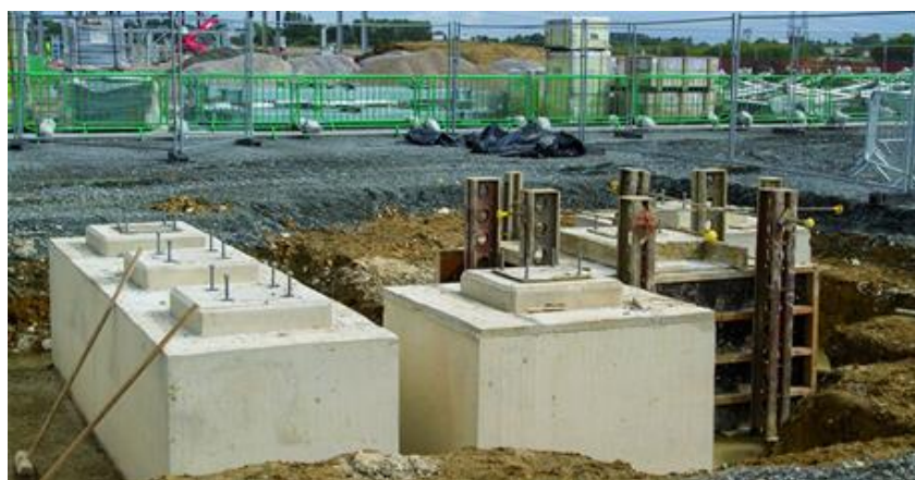
Rys. 3.20. Budowa lądowej stacji elektroenergetycznej
