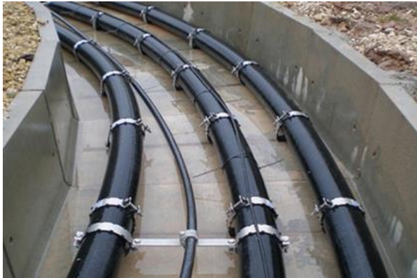
Fot. 3.3. Sposoby układania podziemnej linii kablowej: linie kablowe w ziemi (1), linie kablowe w przepustach (2) linie kablowe w kanale kablowym (3), tunel kablowy (4)
