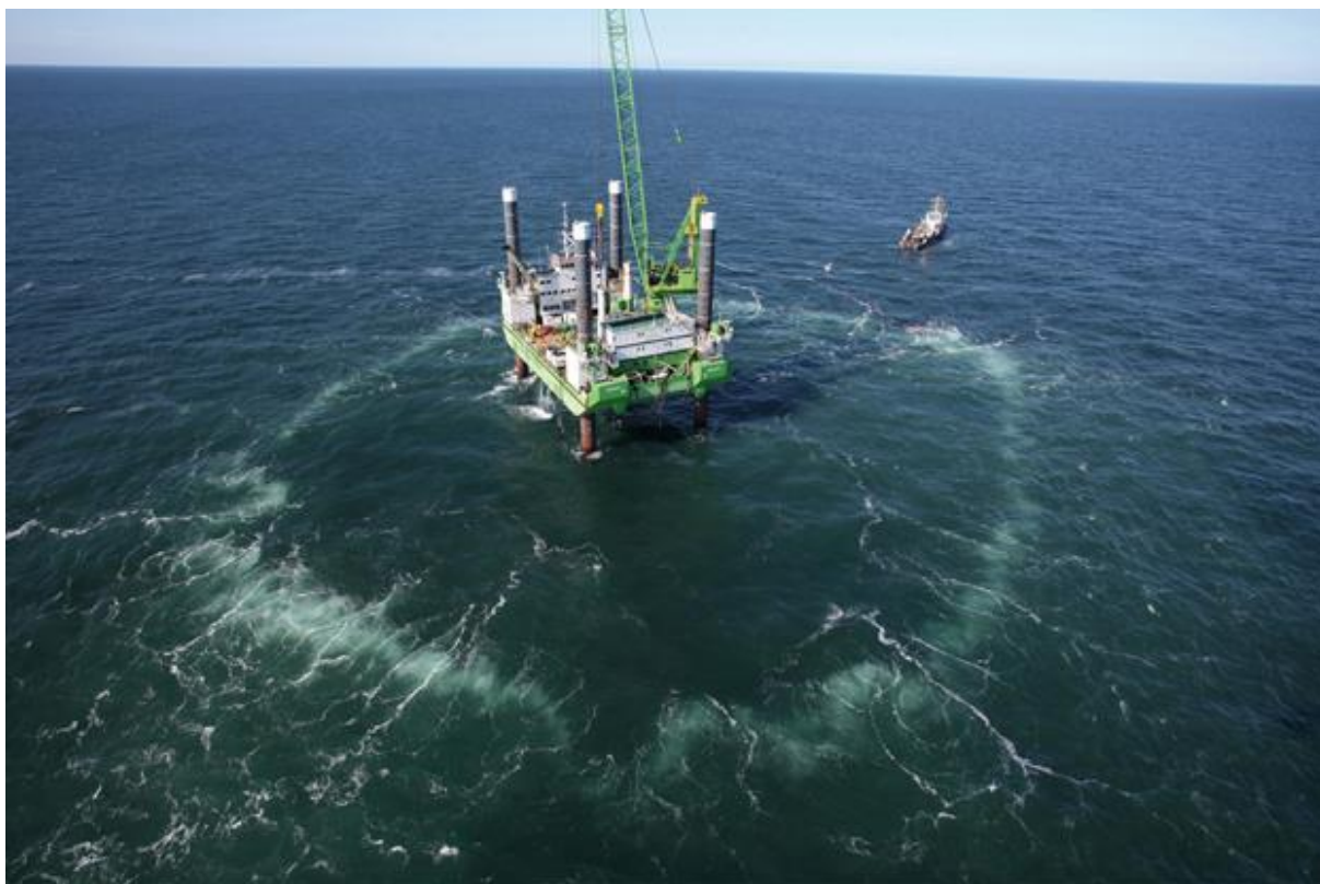
Rysunek 14. Praca kurtyny bąbelkowej podczas budowy MFW Borkum West II
