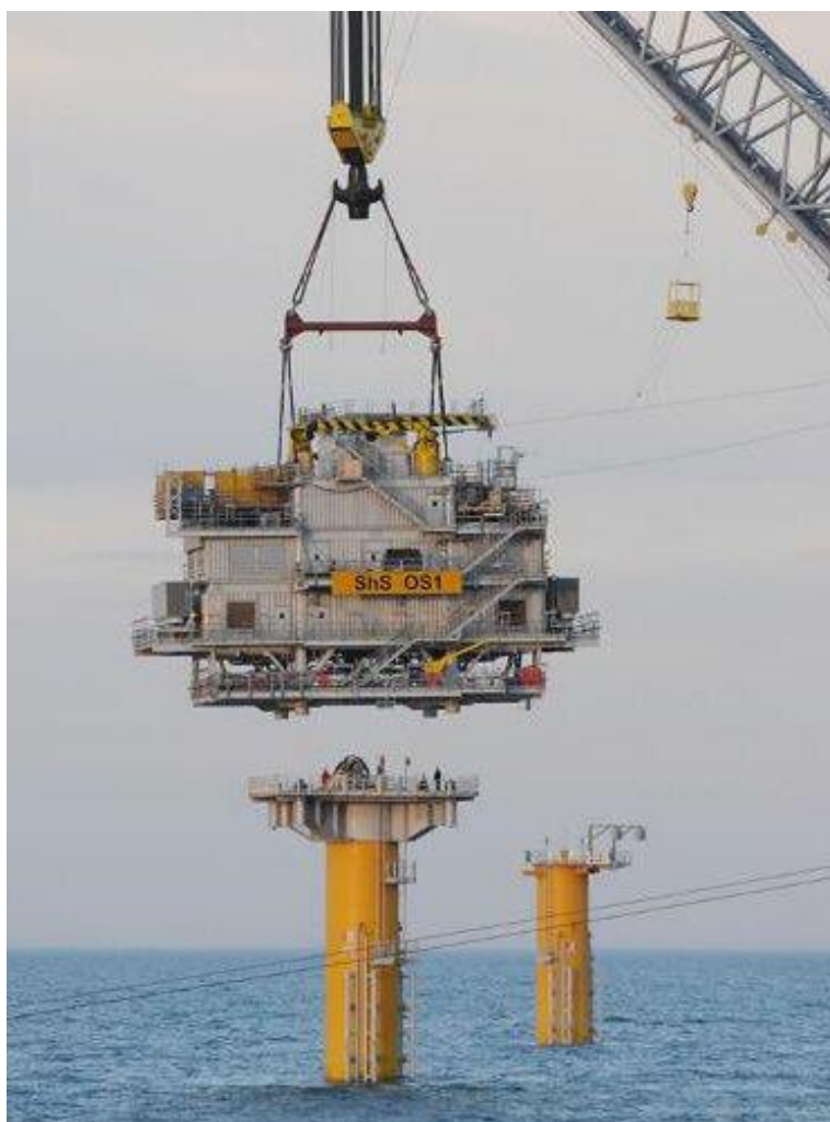
Fotografia 5. Montaż platformy stacji elektroenergetycznej na fundamencie monopalowym
