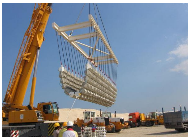
Fotografia 4. Elastyczne materace betonowe
