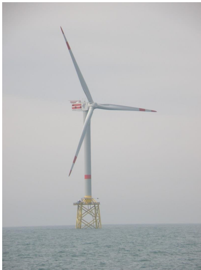
Fotografia 1. Morska elektrownia wiatrowa
